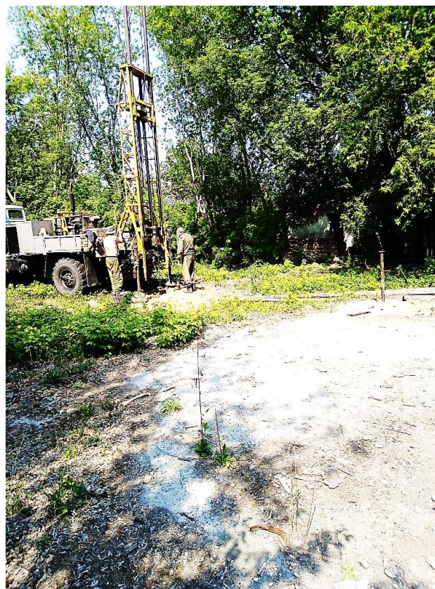
Рисунок 1.2 – Полевые работы. Бурение скважин
