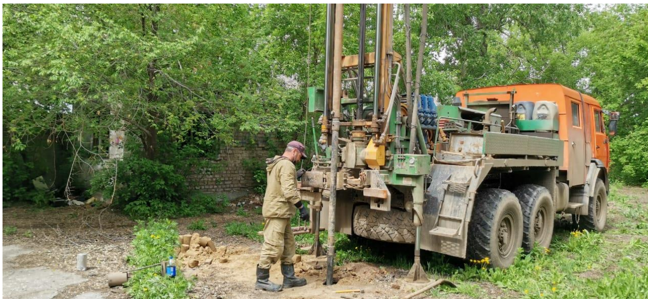
Рисунок 1.1 – Полевые работы. Бурение скважин
